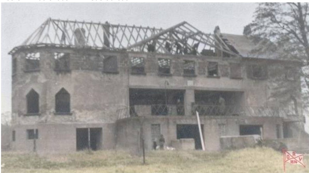
Das ORV Bootshaus im Wiederaufbau
